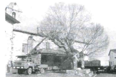
El olmo de El Rasillo, durante los trabajos realizados para evitar la fractura total del tronco
