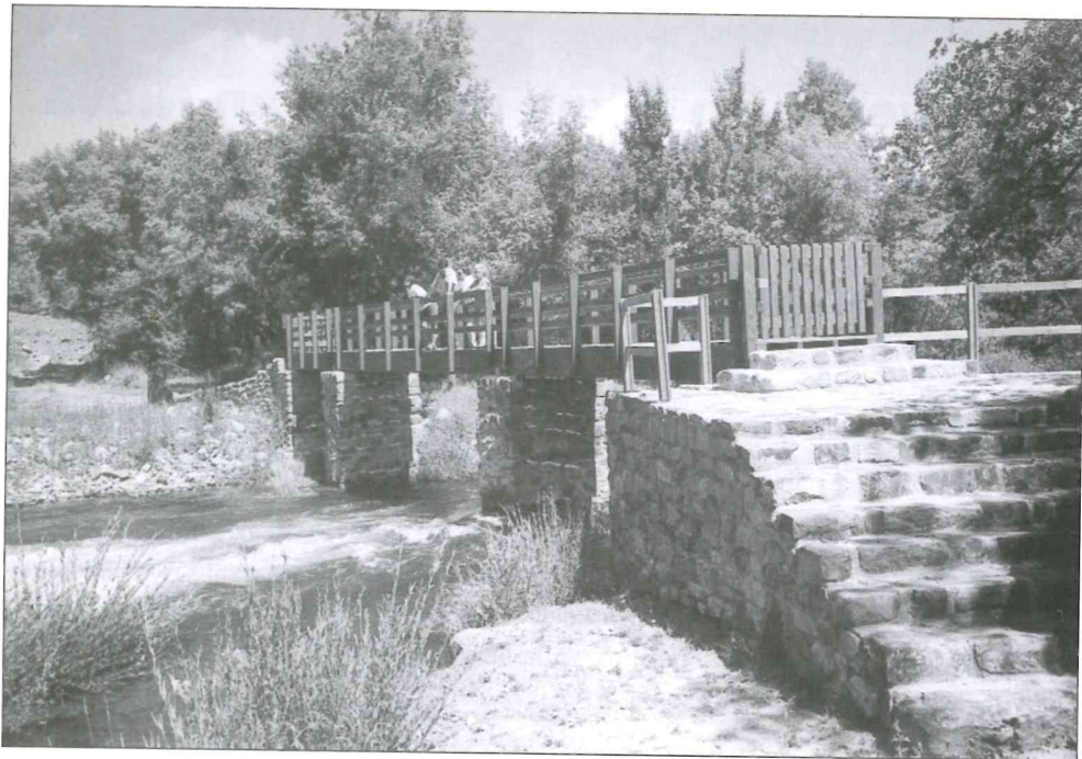
Puente de madera reconstruido.
