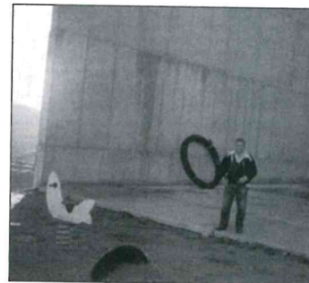
El alcalde en las obras del frontón.
